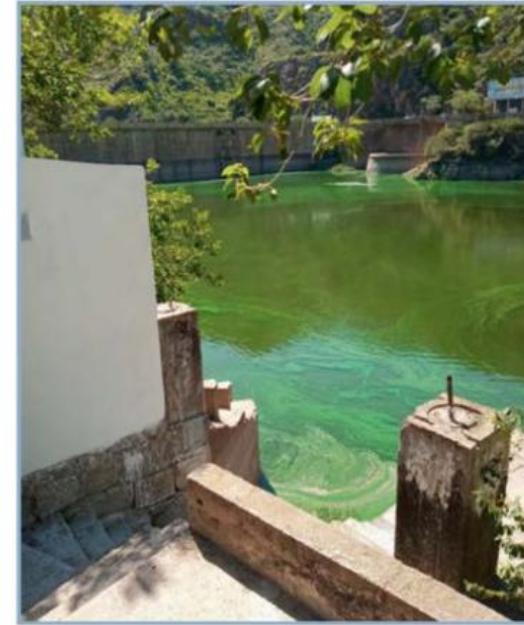
SAN ROQUE-DAMM CORDOBA, ARGENTINIEN
